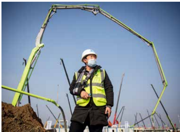
袁天雄在武汉火神山医院建设现场。这个土生土长的武汉人，见证了火神山医院由无到有的全部过程。
