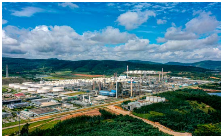
位于云南安宁市的云南裕能新能源电池材料有限公司。安宁工业园区是云南省重点产业园区之一，也是滇中新区的产业核心发展区。（摄影/熊瑛万旭）
